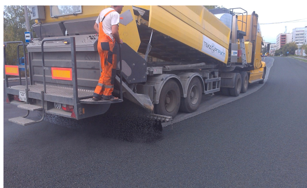
Рис. 3. Устройство шероховатой поверхностной обработки с применением битума и черного щебня с синхронным распределением материалов по технологии «Чип Сил» (ремонт улицы в г. Челябинске, 2015 г.)
