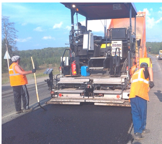
Рис. 1. Устройство слоев износа из ЩМА (ремонт автомобильной дороги Пермь – Екатеринбург, 2015 г.)
