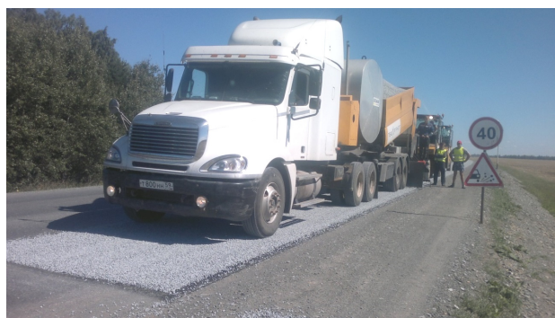
Рис. 4. Устройство шероховатой поверхностной обработки с применением битумной эмульсии и мытого щебня с синхронным распределением материалов по технологии «Чип Сил» (ремонт автомобильной дороги Пермь – Екатеринбург, 2015 год)
