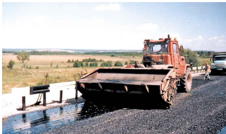
Рис. 2. Устройство шероховатой поверхностной обработки с применением битума и щебня с отдельным распределением материалов
